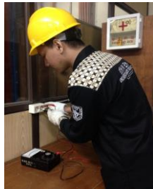
Gambar 8.9. Pengujian Instalasi Listrik Rumah Tinggal
