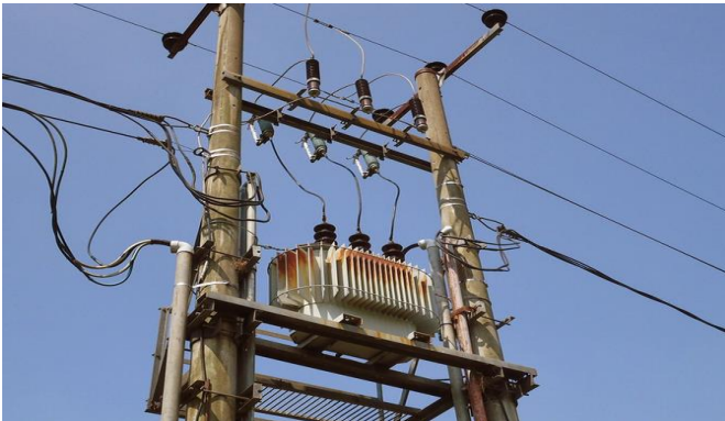
Gambar 1.12. Jaringan Distribusi Listrik Udara
