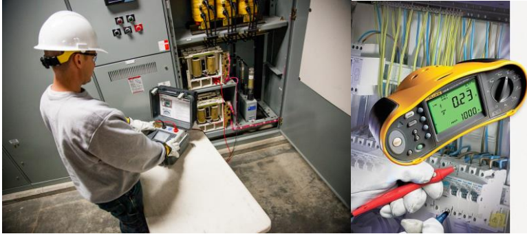
Gambar 4.11. Pelaksanaan pengujian sistem tenaga listrik
